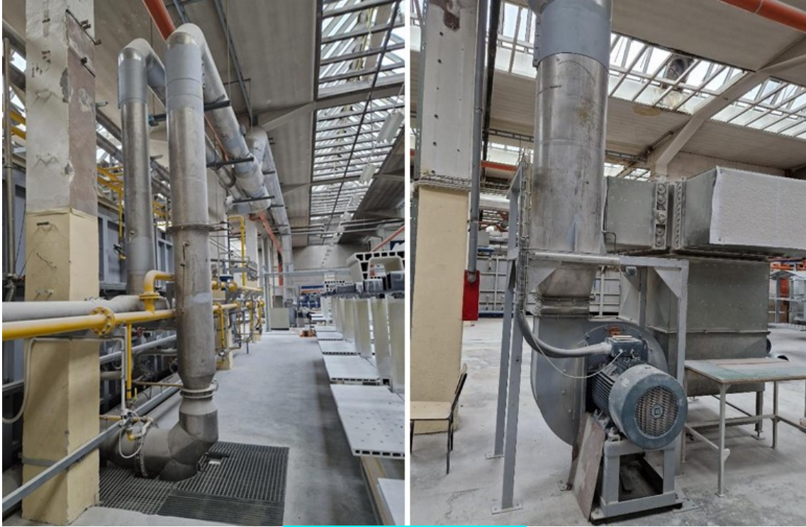
Ducto de ar com ventilador
